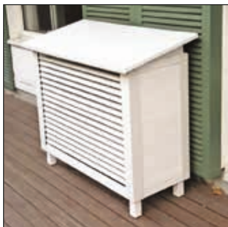
Huset består av en trekasse på bein, med faste sider og en åpen sjalusifront. Kassen er uten bak-kledning. Det gjør at det er plass til å montere utedelen til varmepumpen, samtidig som det sikrer en god luftsirkulasjon. Øverst er kassen lukket med et tak som er fleksibelt. Det kan nemlig legges ned, slik at det kan brukes som avlastningsbord når vi griller.
