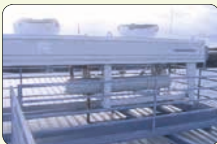
En Guntner-kondensator af type S-GVH med underkøler på maskinrummets tag.
