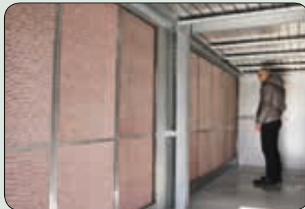
Ved at anvende FA6 indirekte evaporative kølere, forhindres opfugtning af indblæsningsluften til lokalerne.
