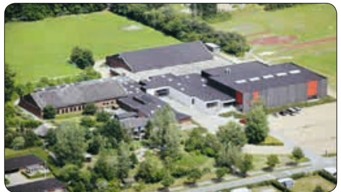
Det er varmegenvinding fra fritidscentrets svømmehal.
