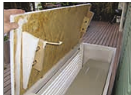
De kileformede gavlene under taket kan dyttes inn, slik at platen ligger vannrett og kan brukes som bord. I fronten er det smale lameller. Det gjør at luften kan sirkulere.
