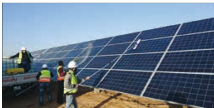
Her vaskes solcelleparken for hånd ved Scantec Solar sitt anlegg i Jordan. Men nå har forskere robotisert renholdet for å både spare vann og øke produktiviteten fra solkraftverk.
