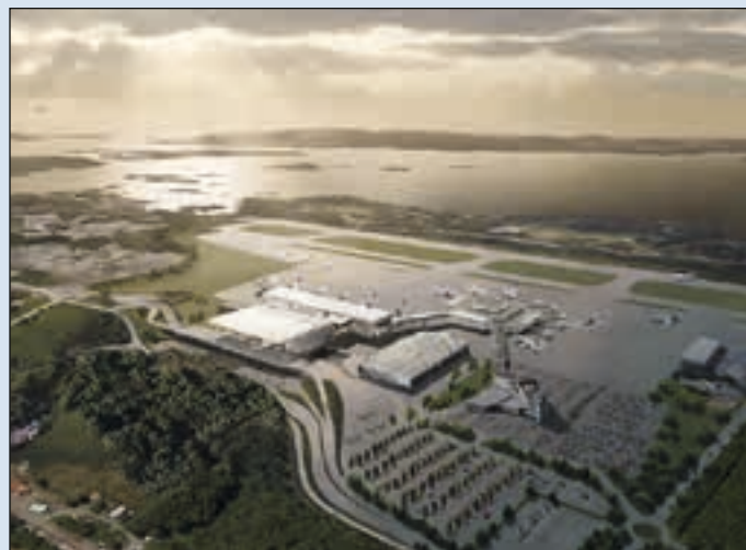
Bergen lufthavn Fleslands nye terminal T3, får energieffekteringshjelp fra en saltblanding fordelt på 44.000 plastceller. Foto: Avinor
