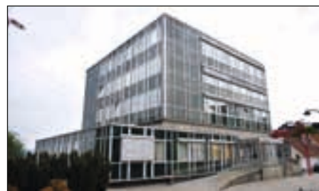
Stavanger Rådhus skal oppvarmes varmepumpe basert på kloakkvann.
