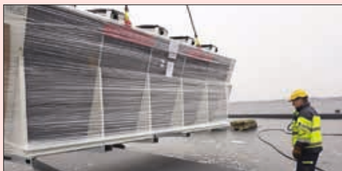
Den luftkjølte CO 2 -gasskjøleren settes på plass på taket av fabrikk-anlegget.
