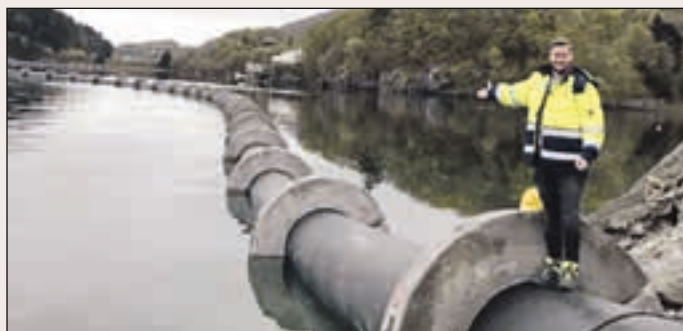
En milpæl i prosjektet ble nådd tidlig i mai, da et 2,2 kilometer langt rør ble slept inn i Puddefjorden. Det skal i første omgang bidra til en kapasitet på 10 MW kjøling fra prosjektet.
