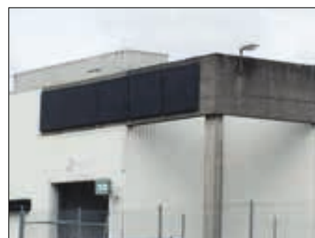
De nye panelene erstatter vegg og takplater, og har lavere vedlikehold enn vinduer med 30 års garanti. Panelene kan leveres i alle fasonger og farger opptil 12 kvadratmeter pr. plate.
