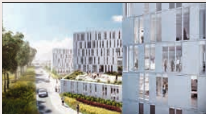
Abels hus er første kontorbygg med miljøklassiferingen BREEAM NOR Excellent i Midt-Norge.
