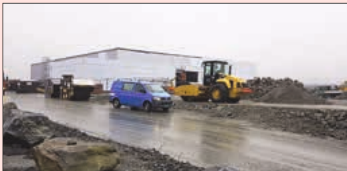
Det nye bygget til Alna Margarinfabrikk tar form.
