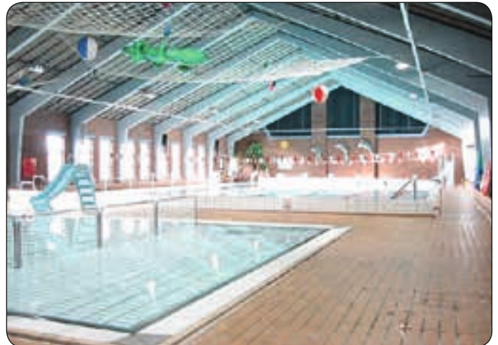
Det er varmegenvinding fra fritidscentrets svømmehal.
