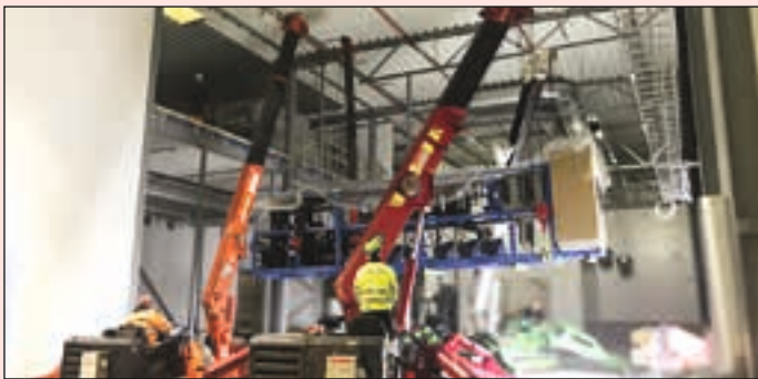
Full konsentrasjon når hjertet i anlegget, kjøleaggregatet, plasseres på mezzaninen ved hjelp av flere kraner.
